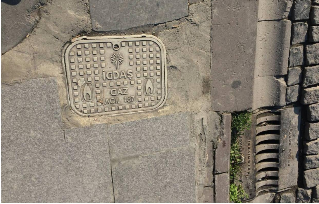
Şekil.5.66. Sultanahmet Meydanı'nda kullanılan, kanalizasyon ızgarası ve doğalgaz bakım kapağı (Elif GÜNER)
