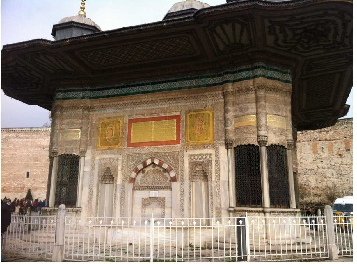
Şekil 5.38: Sultanahmet Çeşmesi (ELİF GÜNER)
