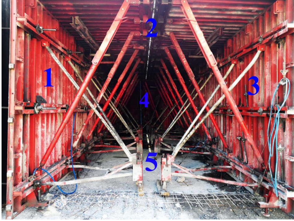
Şekil 4.3 Tünel Kalıp Sistemi ve oluşturduğu hücre hacimleri.
