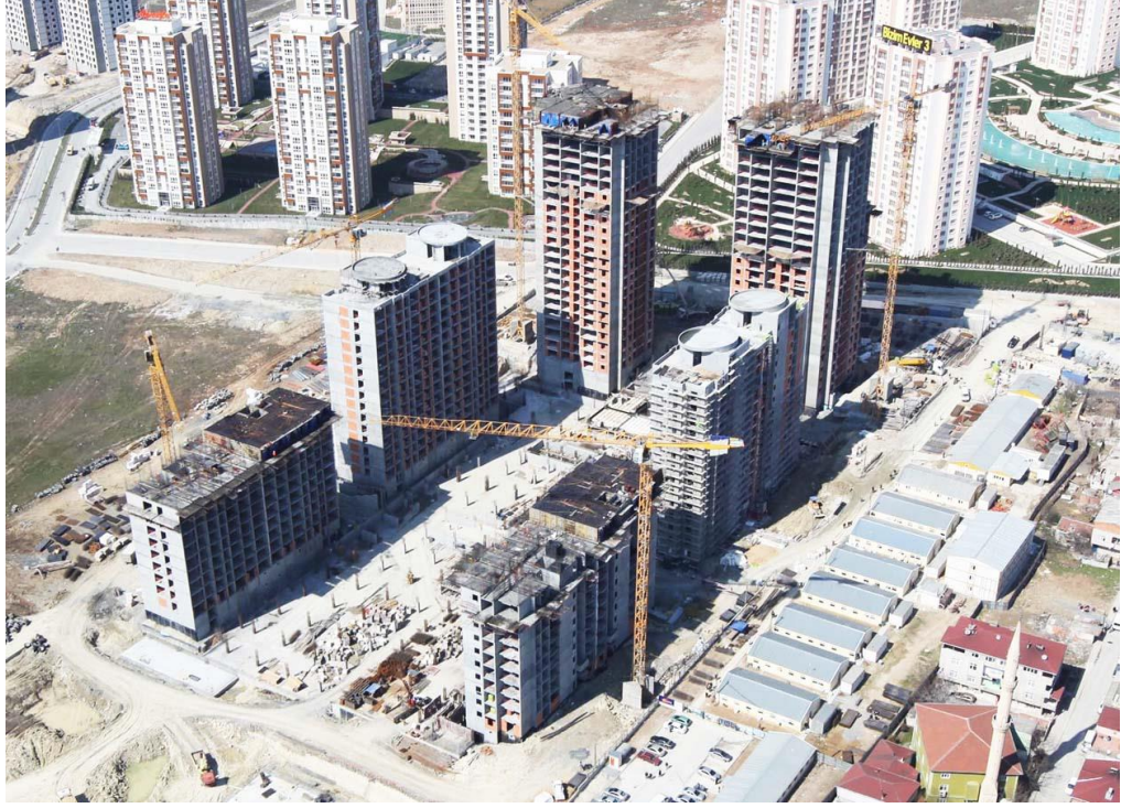
Şekil 4.29. Kule vinç ve kalıp takımları organizasyonu
