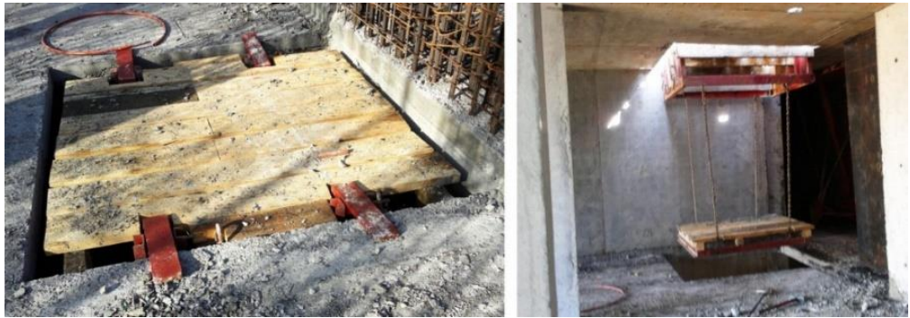
Şekil 4.9. Asansör Kuyusu ve Şaft boşlukları için Sahanlık İskelesi Kurulumu Bizimevler-6 Şantiyesi
