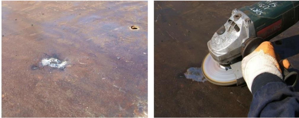
Şekil 4.52. Kalıp yüzeyindeki küçük deliklerin kapatılması
