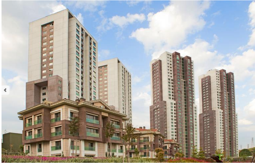
Şekil 7.10. Ön üretimli Beton Cephe Panelleri ile cephe kaplaması.
