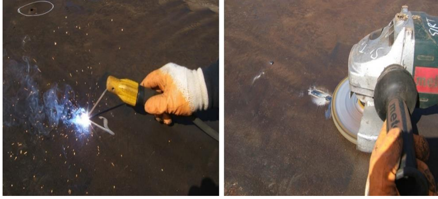
Şekil 4.53. Kalıp yüzeyindeki küçük deliklerin kapatılması
