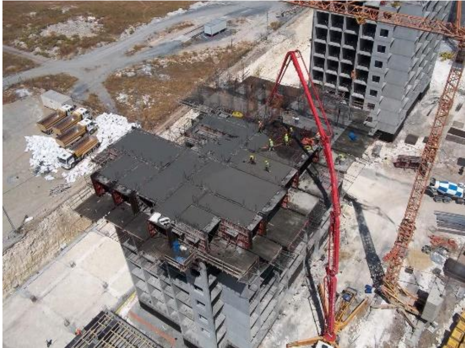
Şekil 4.46. Tünel Kalıpta rotasyon aşamaları-2
