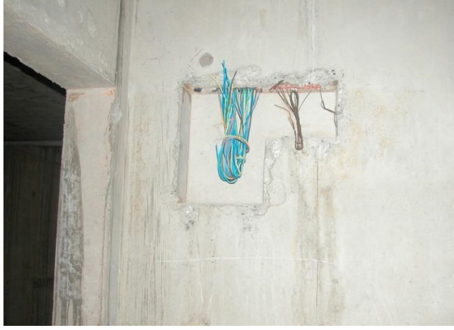
Şekil 4.24. Sigorta panosu için perdede bırakılan rezervasyon Bizimevler-2 Şantiyesi
