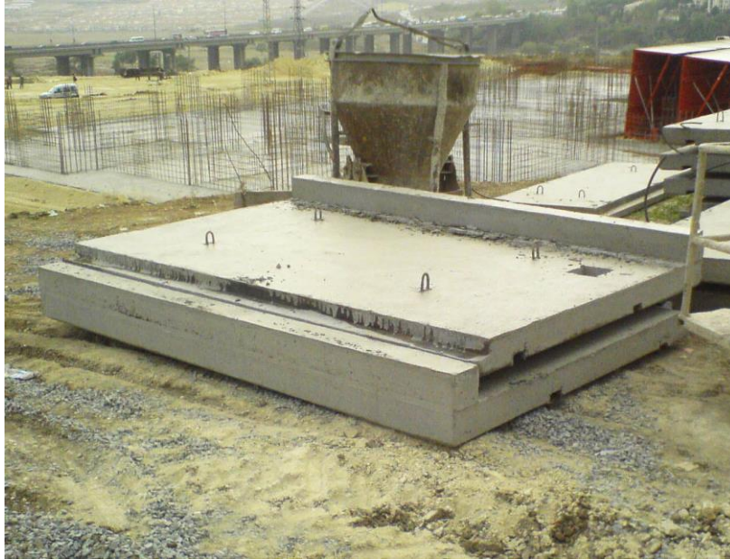
Şekil 4.25. Ön Üretimli sahanlık prekastı Bizimevler-1 Şantiyesi
