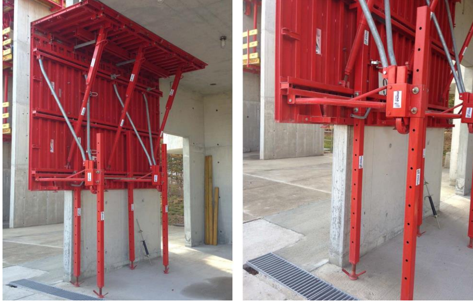
Şekil 7.5. Teleskopik Tünel Kalıp ayakları ile kalıp kurulumu
