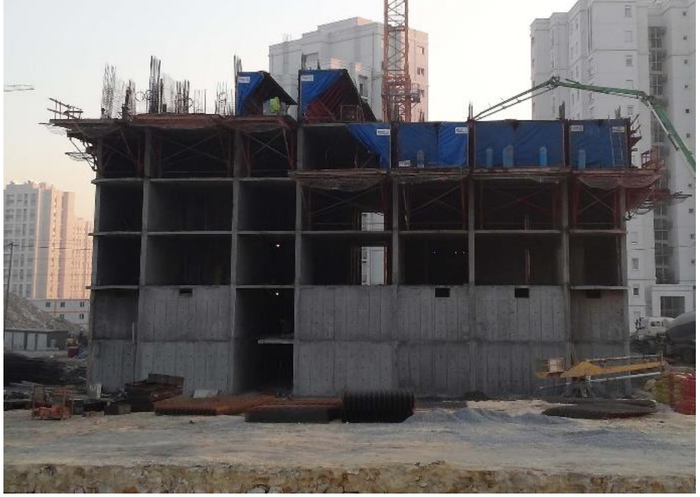
Şekil 4.41. Tünel hacimlerinin brandalarla kapatılarak ısıtılması.
