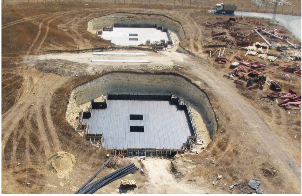
Şekil 4.37. Radye Temel Kalıbı ve Bina Çevresi Hafriyatı Bizimevler-1 Şantiyesi
