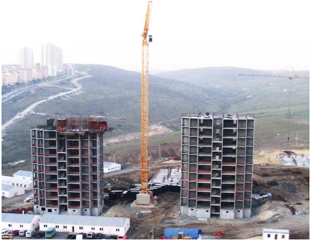
Şekil 4.28. Sabit vinçlerle çalışma
