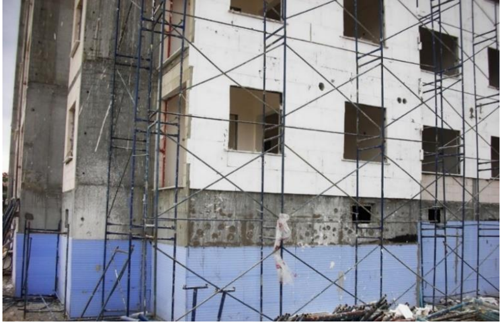
Şekil 7.8. Dış cephe imalat örneği.
