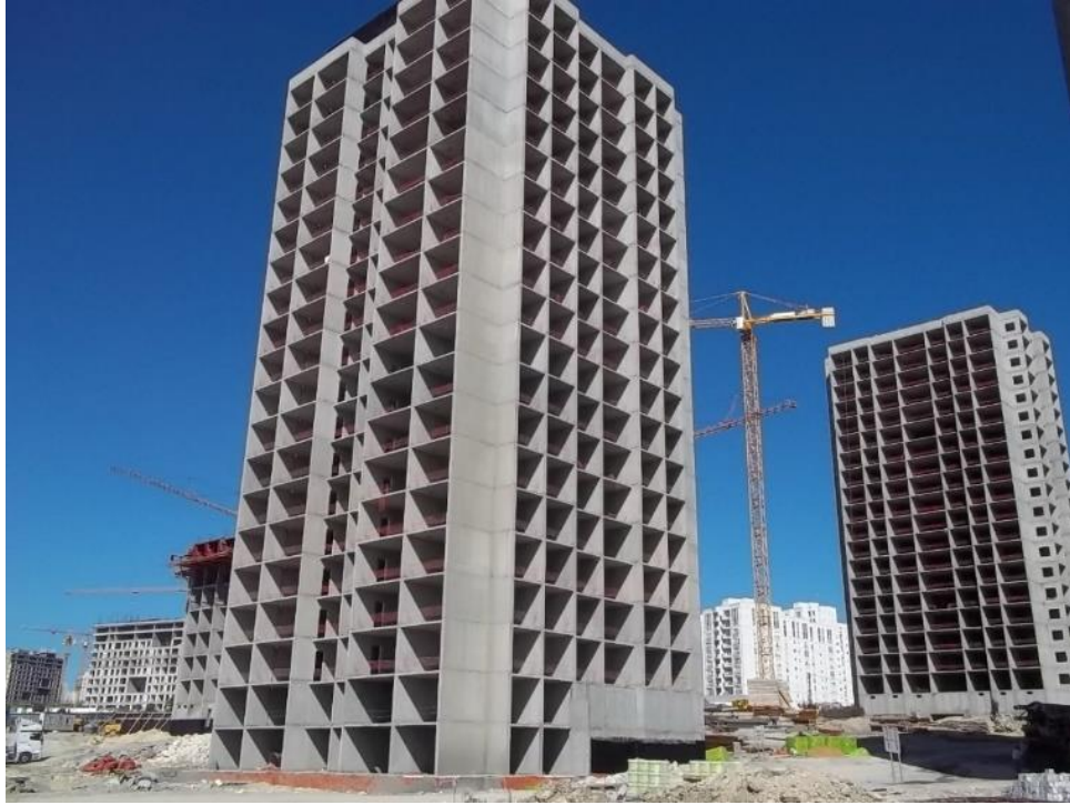
Şekil 5.1. Tünel Kalıpla İnşa edilmiş taşıyıcı perdelerden oluşan bir bina Bizimevler-4 şantiyesi
