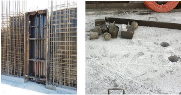
Şekil 4.12. Duvar ve döşeme rezervasyon elemanları
