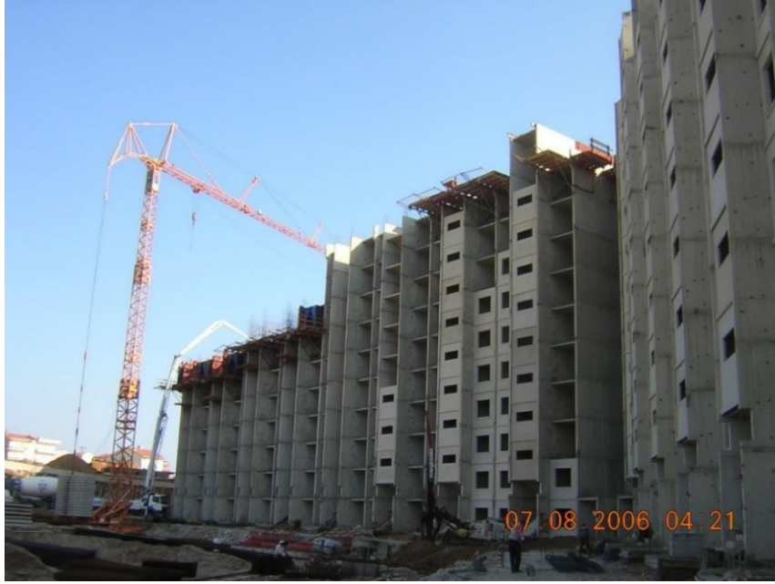
Şekil 7.9. Ön üretimli Beton Cephe Panelleri.
