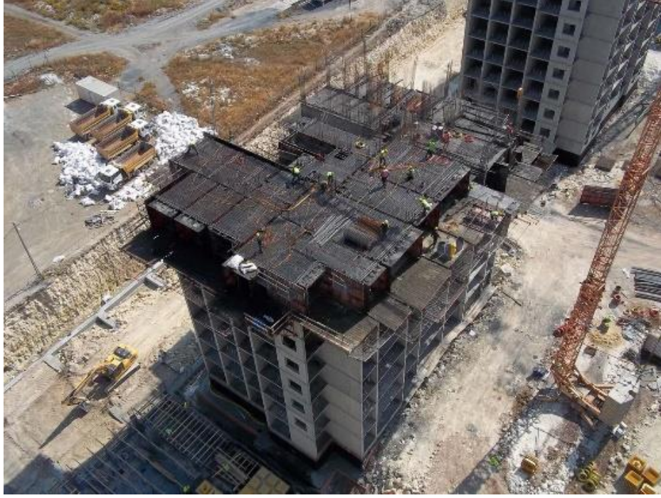
Şekil 4.45. Tünel Kalıpta rotasyon aşamaları-1
