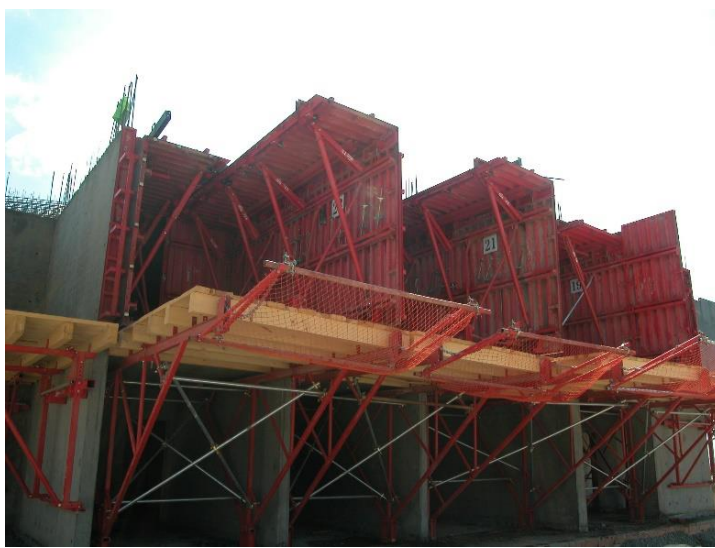
Şekil 7.3. Tünel Kalıp Sökümü ve taşınması. Armutlu Tatil Köyü Şantiyesi.
