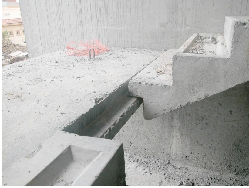
Şekil 4.26. Ön üretilmi merdiven ve sahanlık elemanı Bizimevler-1 Şantiyesi
