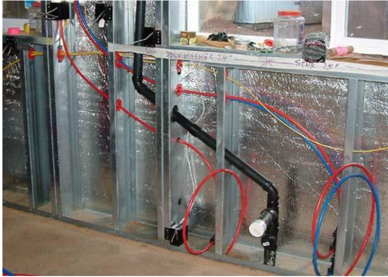
Şekil 7.14. Kuru duvar içerisinde sıhhi tesisat borularının geçirilmesi
