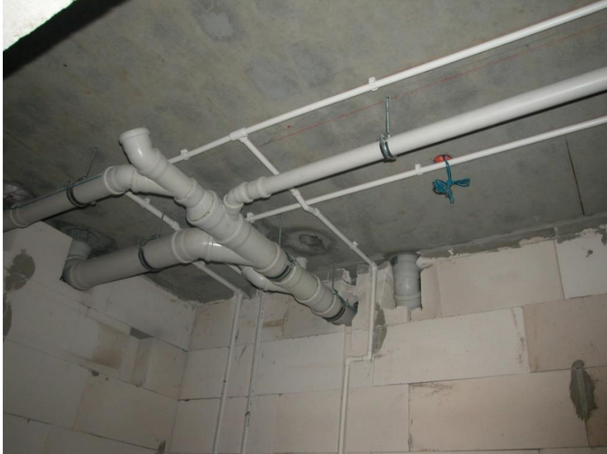
Şekil 7.12. Tünel Kalıp Sisteminde atıksu tesisatı borulaması.
