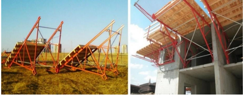
Şekil 4.7. Çalışma İskelesi Kurulum ve Yerine Montaj Aşamaları Bizimevler-1 Şantiyesi
