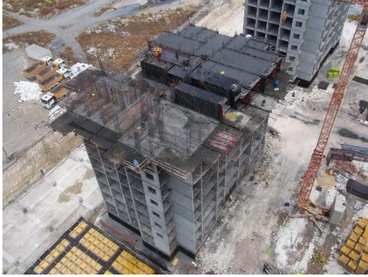
Şekil 4.47. Tünel Kalıpta rotasyon aşamaları-3 Bizimevler-5 Şantiyesi
