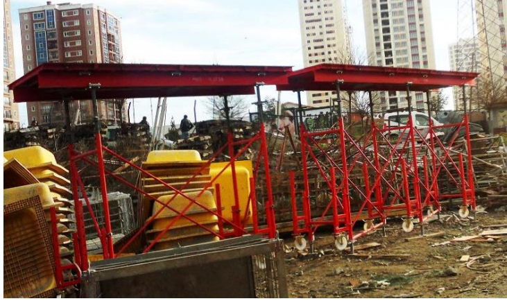
Şekil 7.2. Masa Kalıplar. Bizimevler-6 Şantiyesi.
