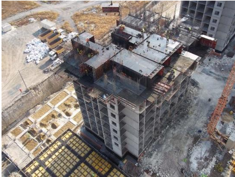
Şekil 4.48. Tünel Kalıpta rotasyon aşamaları-4 Bizimevler-5 Şantiyesi
